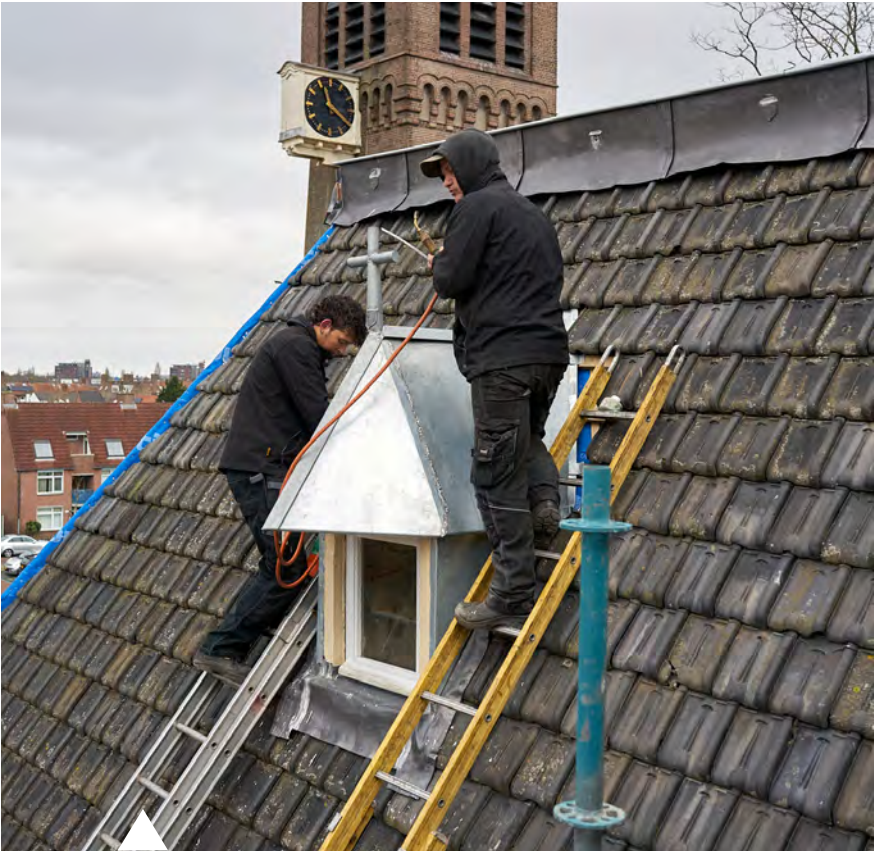
Aanbrengen nieuw zink op de dakkapel van De Pastorie in Diemen DEPASTORIE FOTOSTUDIO
