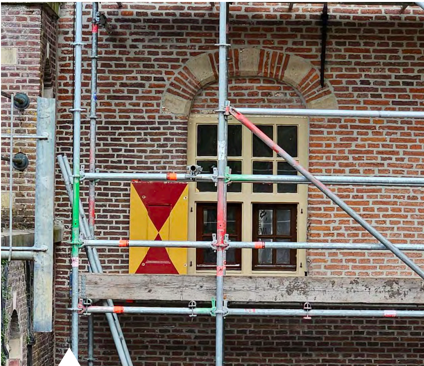
Opzetten proefstukken voor de kleur van het houtwerk bij Kasteel Nederhorst
