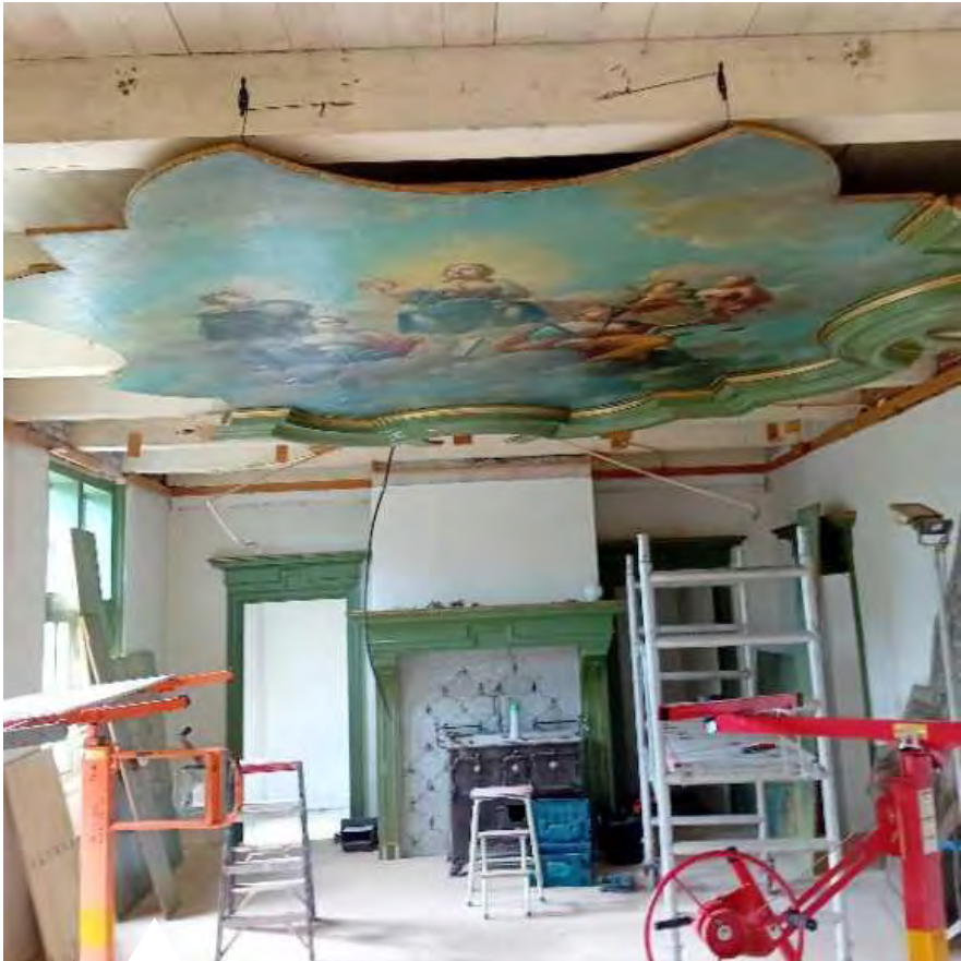
Het plafondstuk van het kasteel wordt gedemonteerd
