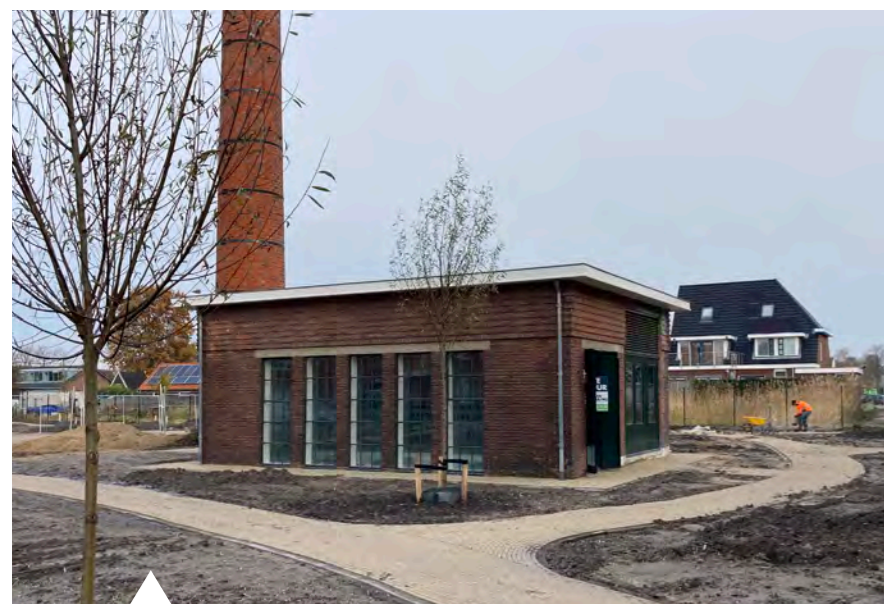
Het gerestaureerde Ketelhuis aan de Bennebroekerweg 10 A in Rijsenhout ARCHIEF STADSHERSTEL
