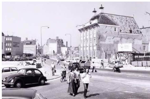
Het Pintohuis na de restauratie in 1975 in de verder nog onttakelde Sint Anthoniebreestraat.
