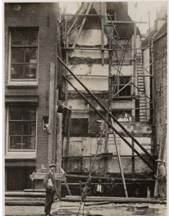
Geldersekade 10 met de sloop van het achterhuis in 1915.
