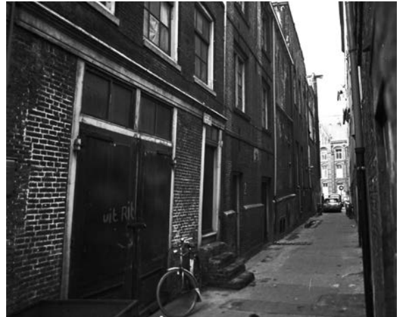
Onkelboerensteeg 2 en 4, met aansluitend de zijgevel van Kloveniersburgwal 47.
