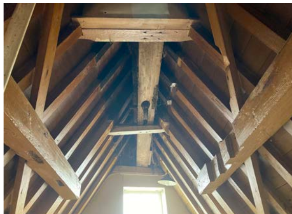
Onder de kap nog een schitterende hijsbalkconstructie.
