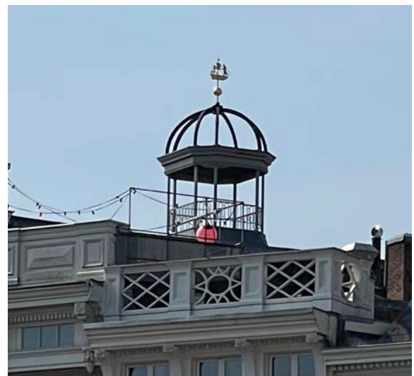
Koepeltje op het dakterras van Geldersekade 6.
