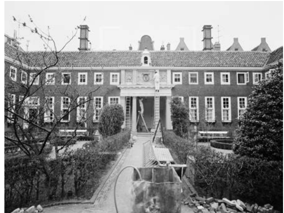
Deutzenhofje, gevel aan de binnenplaats tijdens restauratiewerkzaamheden in 1970.
