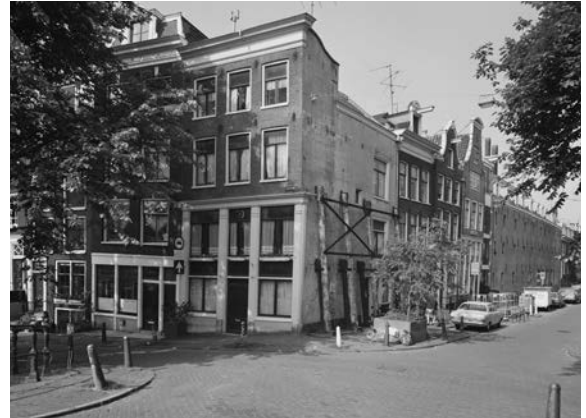
Het hoekpand in de stutten, 1984
