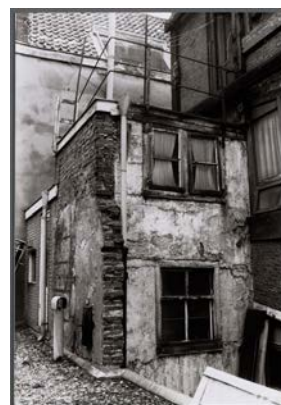
Achterzijde, Kerkstraat 273. Voor de restauratie. Ca 1950.
