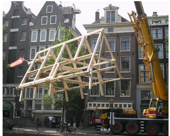
De kapconstructie van nr.34 is midden op de gracht opgebouwd en werd op spectaculaire wijze op zijn plaats getakeld.
