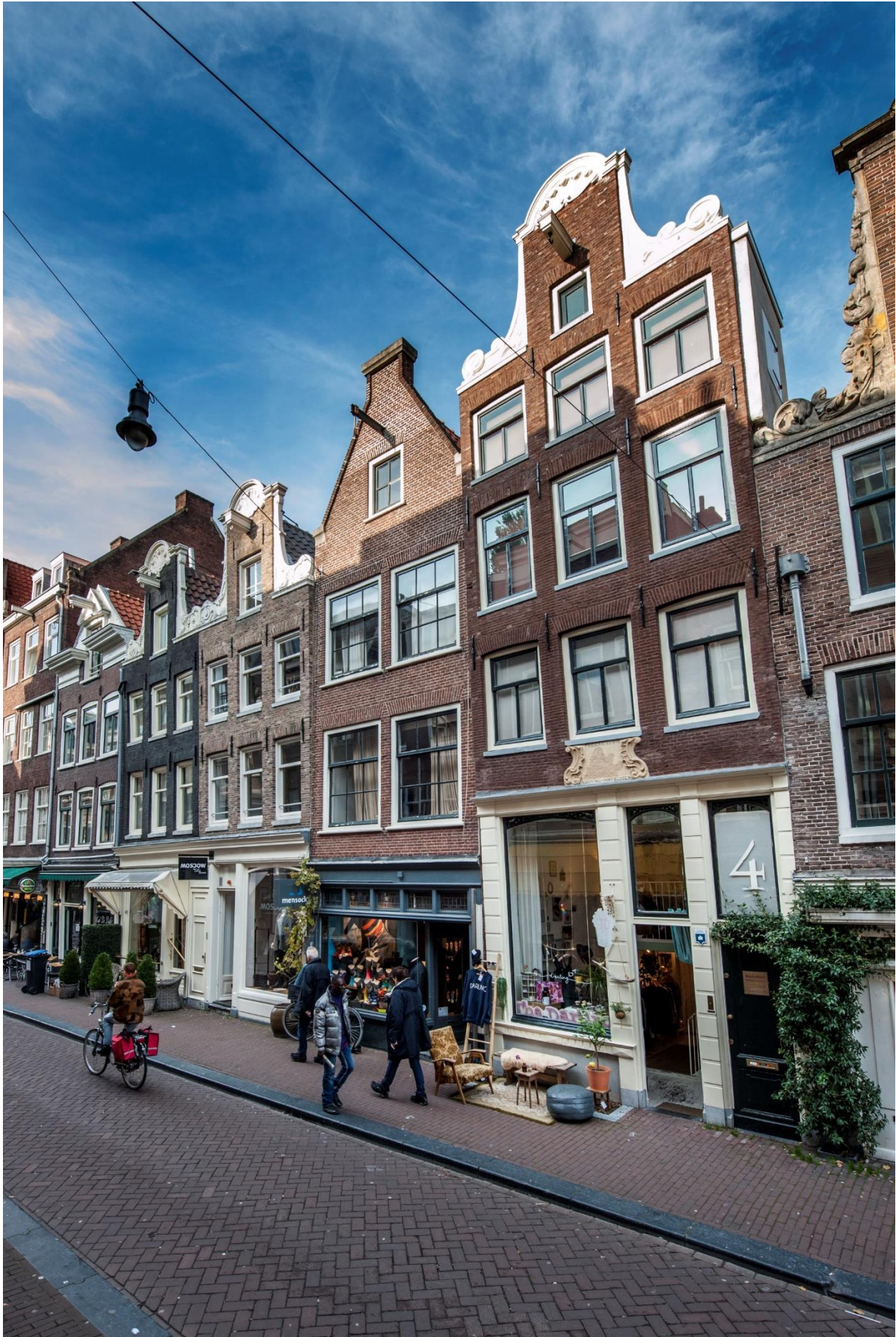
Runstraat 4, Amsterdam na restauratie met een oude top van de monumentenwerf
