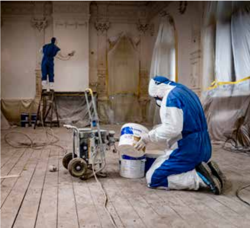
Hollandsche Manege, de foyer in restauratie JAN REINIER VAN VLIET
