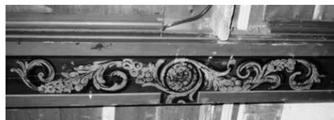
Laat 16de of vroeg 17de eeuwse balk, in 2000 ontdekt onder stucplafond in de recepteeruimte (opkamer) van de apotheek.
