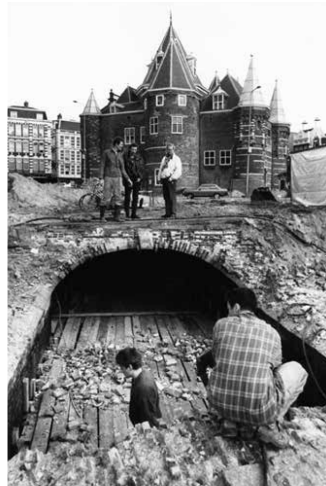
Werknemers van de gemeente Amsterdam bekijken de resten van een reinwaterkelder. Bij graafwerk op de Nieuwmarkt werden verscheidene van dergelijke kelders
