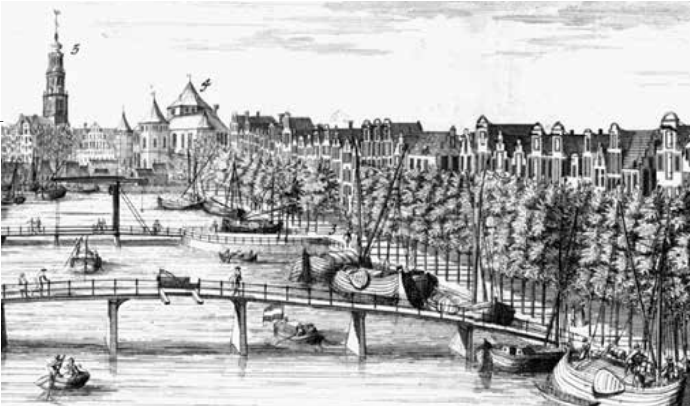
Op een vergroting van een deel van de prent van H. de Leth uit 1730, is de Waterpoortbrug te zien, een houten voetgangersbrug aangelegd in 1482, die nog wel een 'oorgat' heeft. De tweede brug is de Bantammerbrug. Duidelijk is de grote halfronde open plek te zien, tegenover de Stormsteeg, waar voordien het Sint Nicolaasbolwerk had gestaan. (collectie Koninklijk Oudheidkundig Genootschap, Rijksmuseum)
