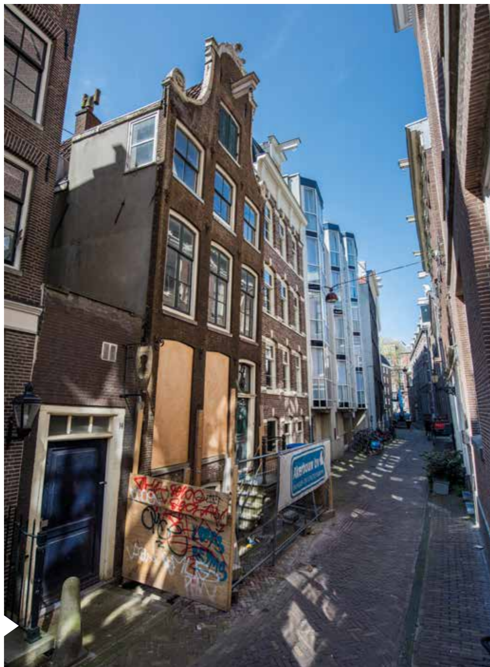
Spinhuissteeg 12 tijdens de restauratie
