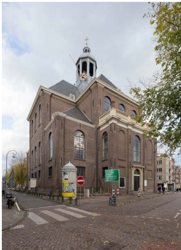
Oosterkerk: het stenen zusje van de Amstelkerk
