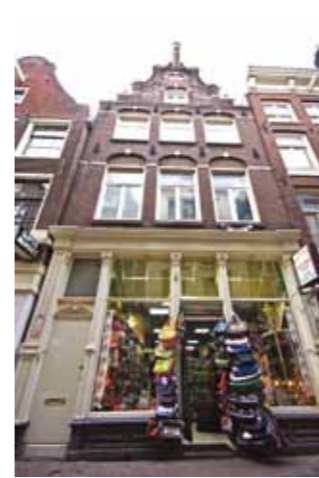
WOON- EN WINKELPAND Lange Niezel 10 In restauratie
