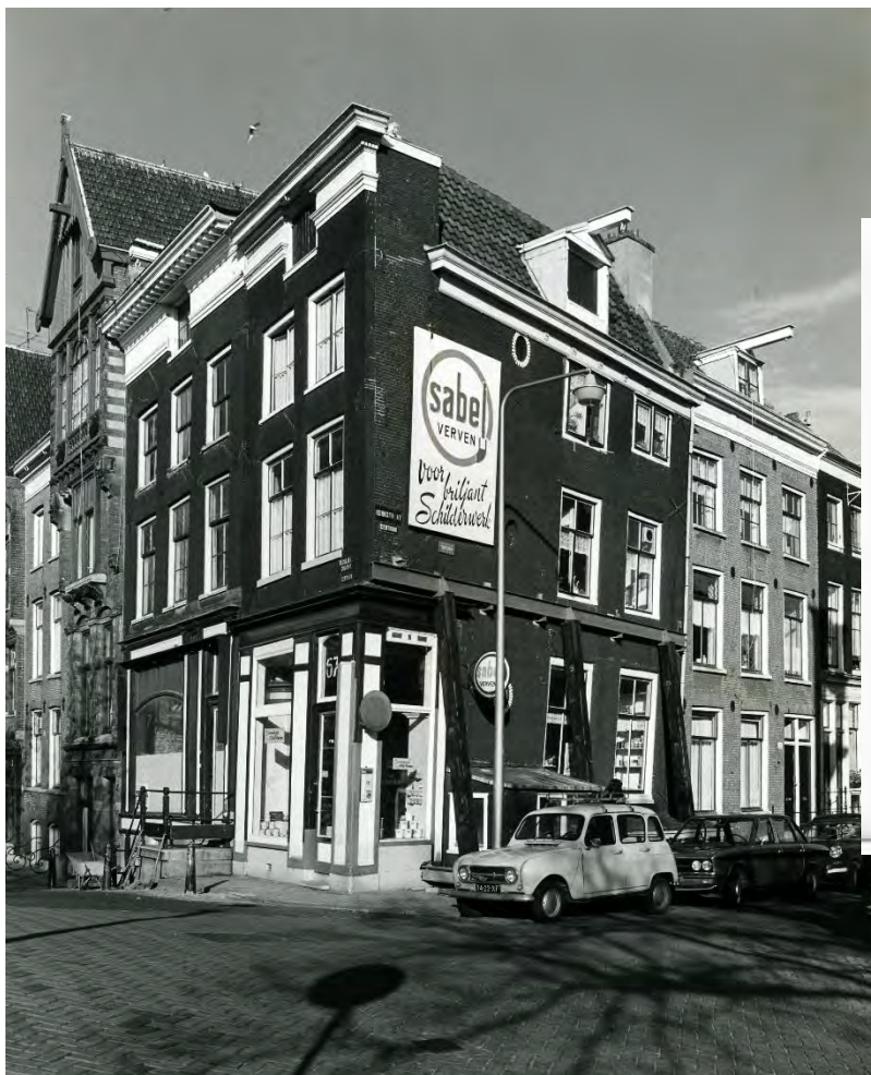
Jarenlang stond ook dit pand in de stutten.
