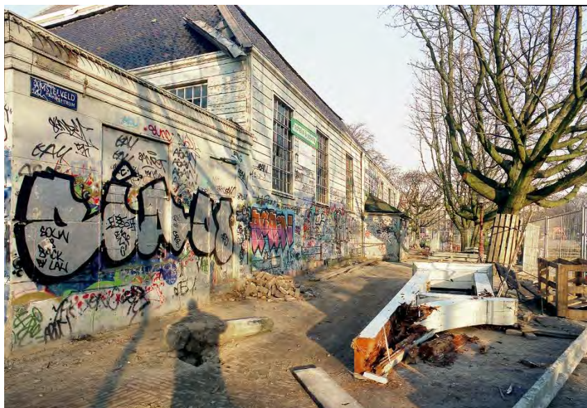
De vervallen Amstelkerk wordt de eerste kerkrestauratie van Stadsherstel. Er volgen zo'n 35 kerkelijke gebouwen in en 45 kilometer rondom Amsterdam.
