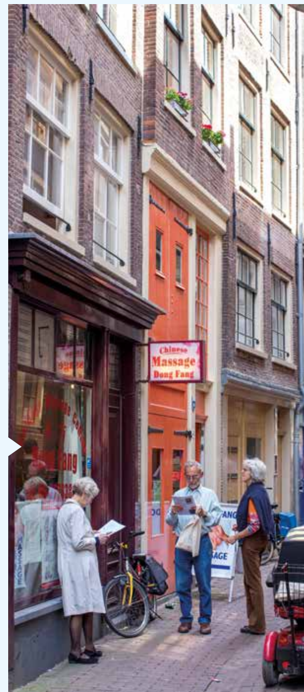
De voorgevels van de panden 2, 4 en 6 na restauratie. Met in de bovenlichten van de pui van nummer 6 het verhaal van deze plek.
