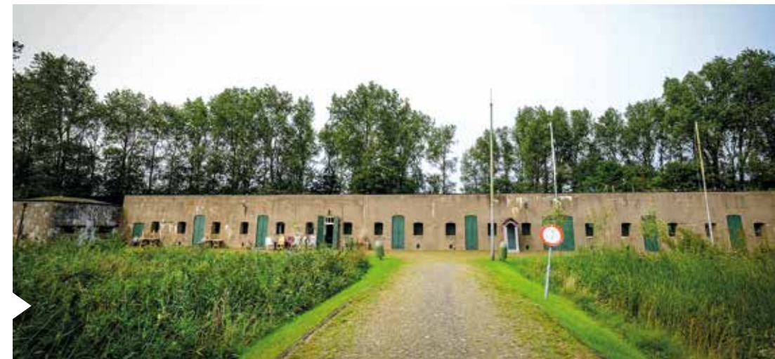
Keelzijde, achterzijde, van het fort. Maar wel de ingang.
