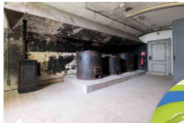
Keuken Fort bij Krommeniedijk met kookketels en afzuigkap, kijkend naar de gang.
