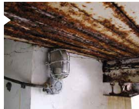
Stalen balken voor restauratie
