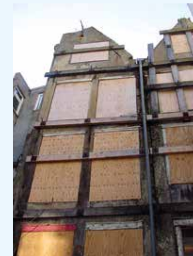
De achtergevel van de panden.
