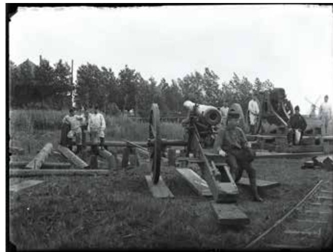
Het gebruik van het smalspoor voor het verplaatsen van veldgeschut. Op de achtergrond is waarschijnlijk de Kringenwetboerderij Zeehoeve aan de oostzijde van Batterij bij Diemerdam te zien. 14 juli 1895
