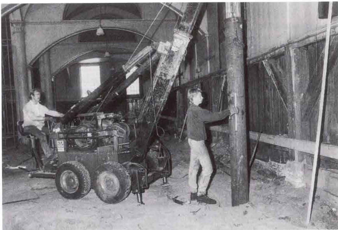
Het aanbrengen van de stalen pulspalen. (Stadsherstel)
