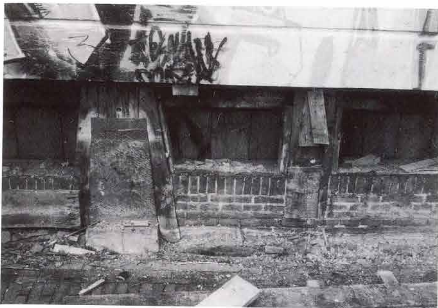
De voetingmuur met de hardstenen neuten waarop de nieuwe stijlen staan voor de bevestiging van de nieuw aangebrachte horizontale delen. (Architectenbureau Prins)
