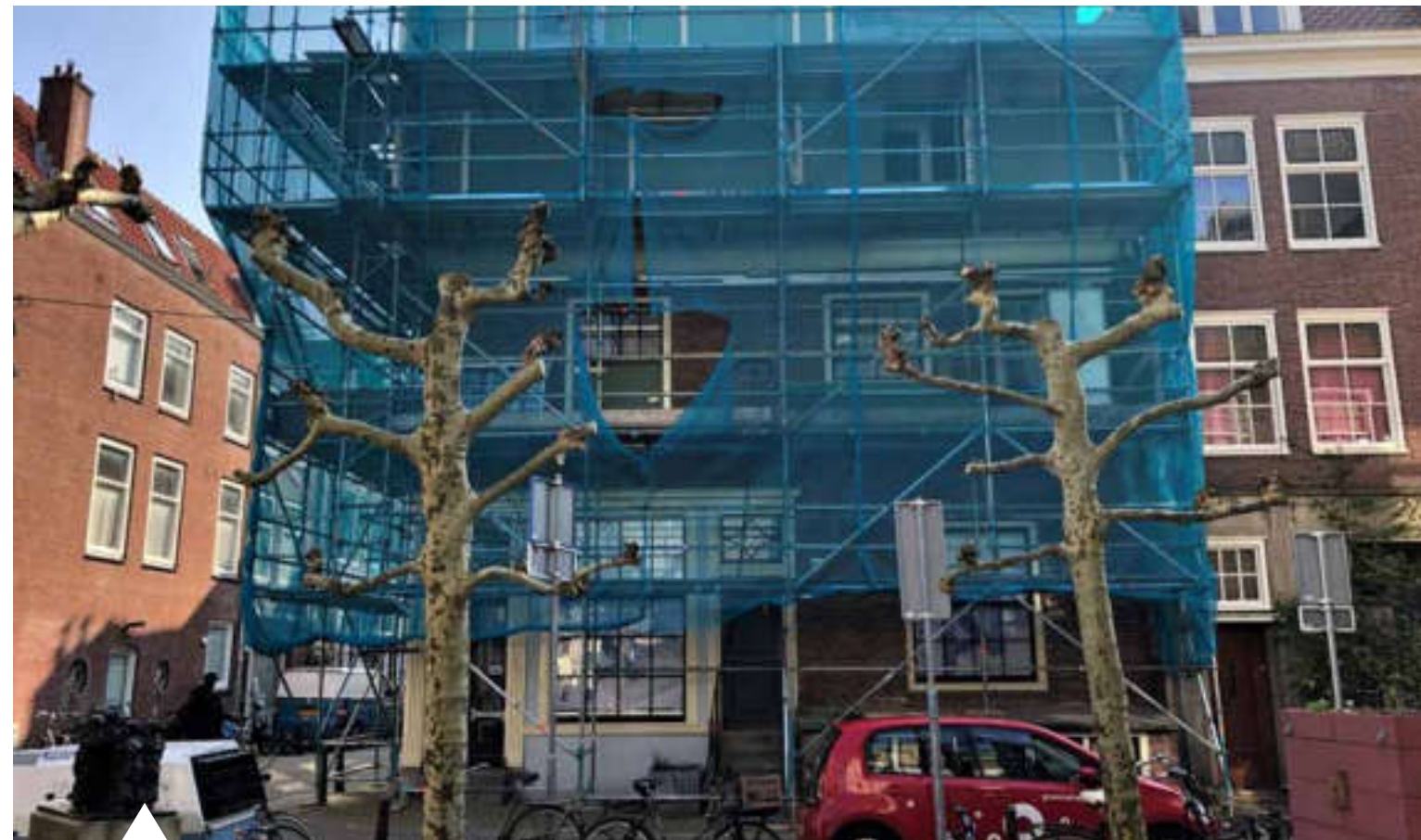
Asbestsanering Weteringstraat 19 ARCHIEF STADHERSTEL
