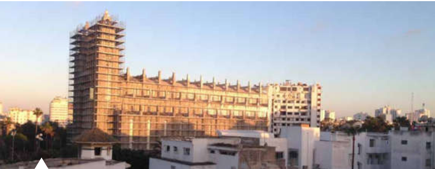
Kathedraal de Sacré Coeur in Casablanca tijdens restauratie ARCHIEF STADSHERSTEL
