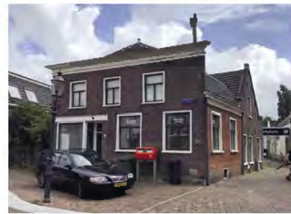
Woonhuis Wilhelminaplein 12, Heemstede Restauratie in voorbereiding
