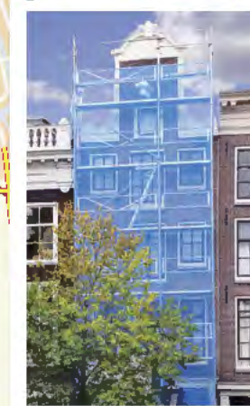
Woonhuis Geldersekade 87, Amsterdam Restauratie in voorbereiding
