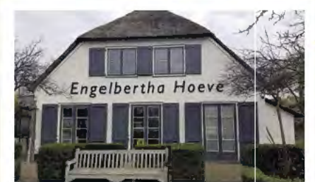
Engelbertha Hoeve (p.24) Hoge Morsweg 140, Leiden Restauratie in voorbereiding
