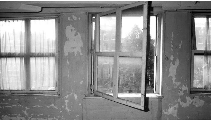
Keizersgracht 695/697 tijdens de renovatie.
